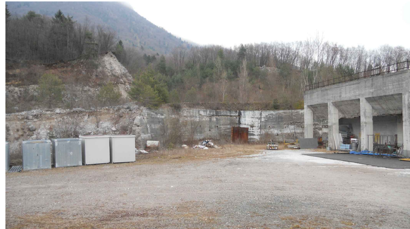
IL MURO DI SOSTEGNO DELLA STRADA PER LE TRAMOGGE
